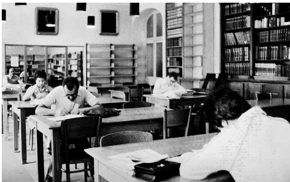
Fig. 3 - La sala di consultazione prima del restauro della sede di via Roma.
